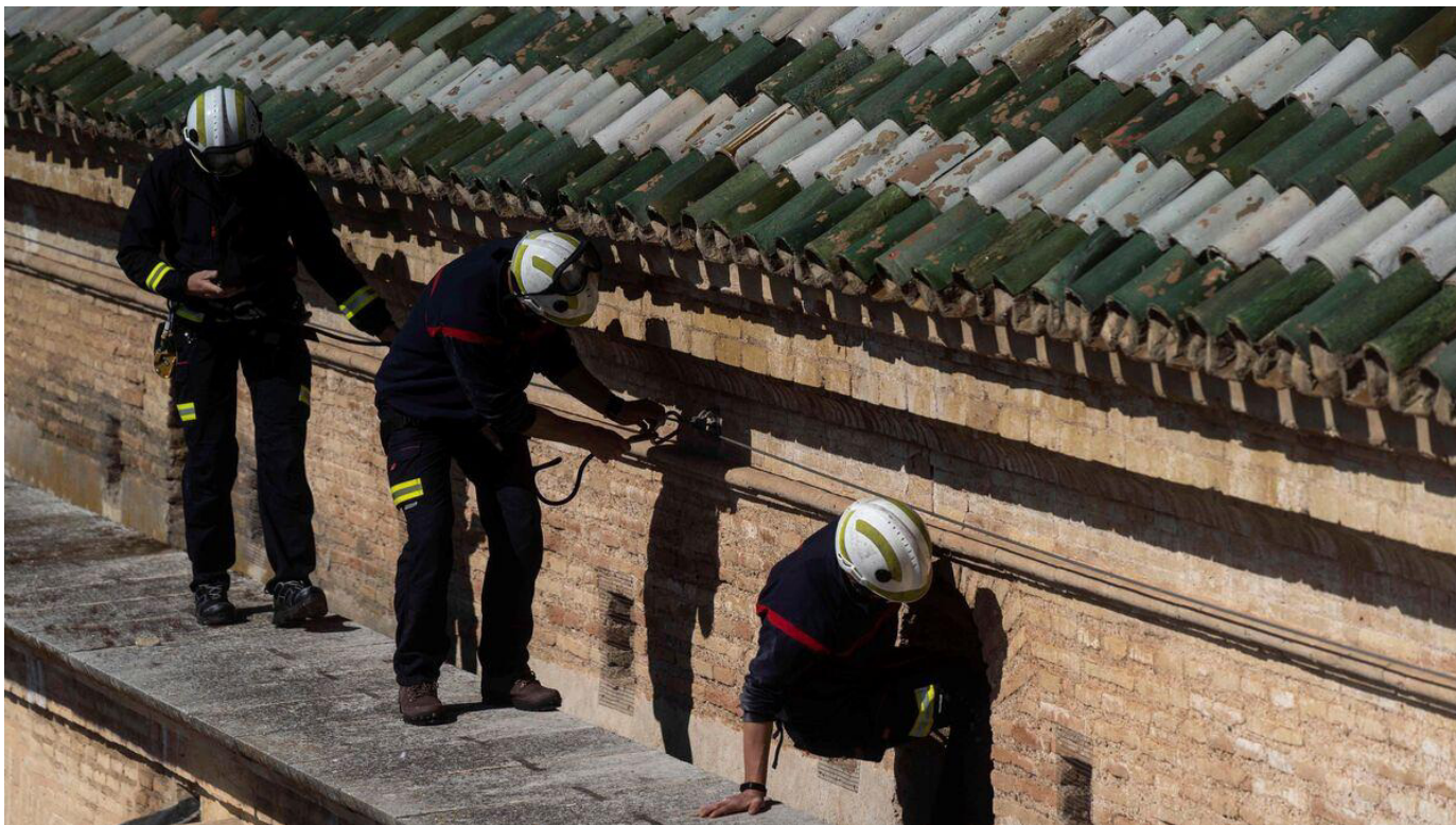
Inspección en los tejados del templo. / RAFA ALCAIDE / EFE
